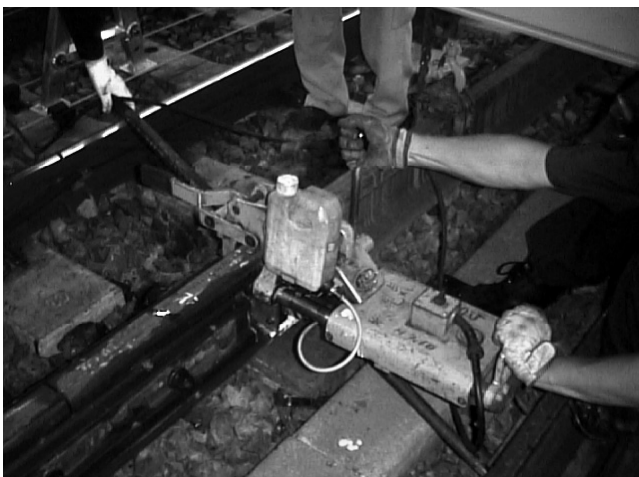
Hình ảnh khoan tại hiện trường
